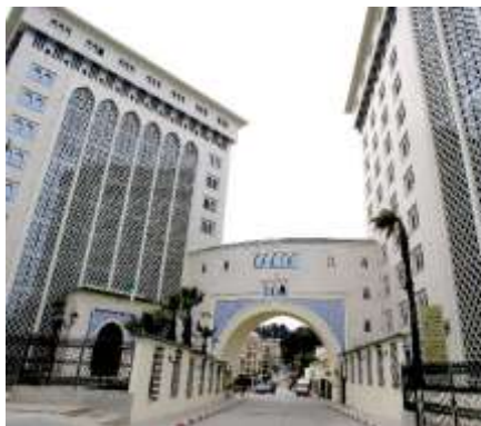
Fig.02 : Ministère de l'Énergie et des Mines à Alger.
