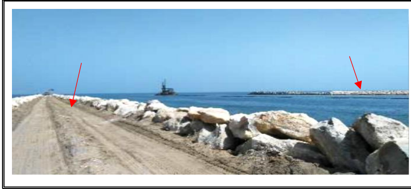
صورة (٤) إنشاء ٢ لسان بحري بمدخل بوغاز أشتوم الجميل
