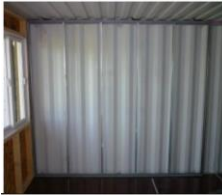
شكل (١٦) مرحلة تأطير الجدران الداخلية وتدعيمها واعدادها لمرحلة العزل الحراري.
