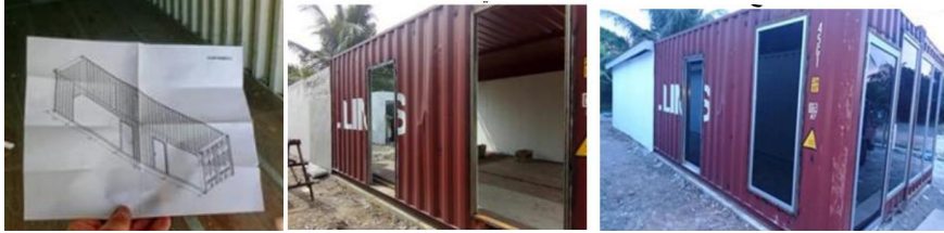
شكل (١٢) توضح مراحل قطع وتأطير الفتحات المختلفة لمباني حاويات الشحن.
