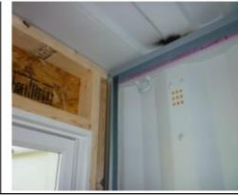
شكل (١٦) مرحلة تأطير الجدران الداخلية وتدعيمها واعدادها لمرحلة العزل الحراري.
