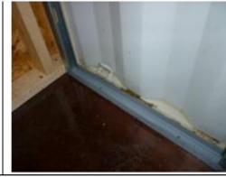
شكل (١٦) مرحلة تأطير الجدران الداخلية وتدعيمها واعدادها لمرحلة العزل الحراري.
