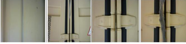
شكل (١٤) توضيح إحكام إغلاق الفجوات عند دمج مساحة حاويتين.
