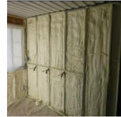
شكل (٢١) يوضح العزل باستخدام رغوة الرش.
