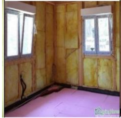
شكل (٢٢) يوضح عزل التغطية الروالت.
