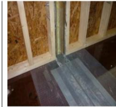
شكل (١٧) يوضح مرحلة عمل الفواصل الداخلية للمبني وفق التصميم. ( https://www.tincancabin.com/lander )
