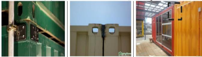
شكل (١٣) يوضح وصالت وتثبيت الحاويات.
