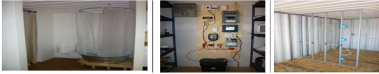
شكل (١٨) يوضح مرحلة عمل التمديدات الكهربائية والصحية للمبنى وفق التصميم.
