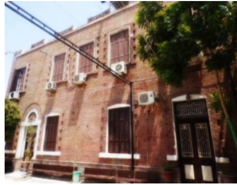
(لوحة رقم 3) الواجهة الجنوبية لسكن
