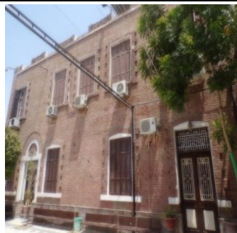
(لوحة رقم 9) الواجهة الجنوبية من سكن الرهبان تصوير الباحثة
