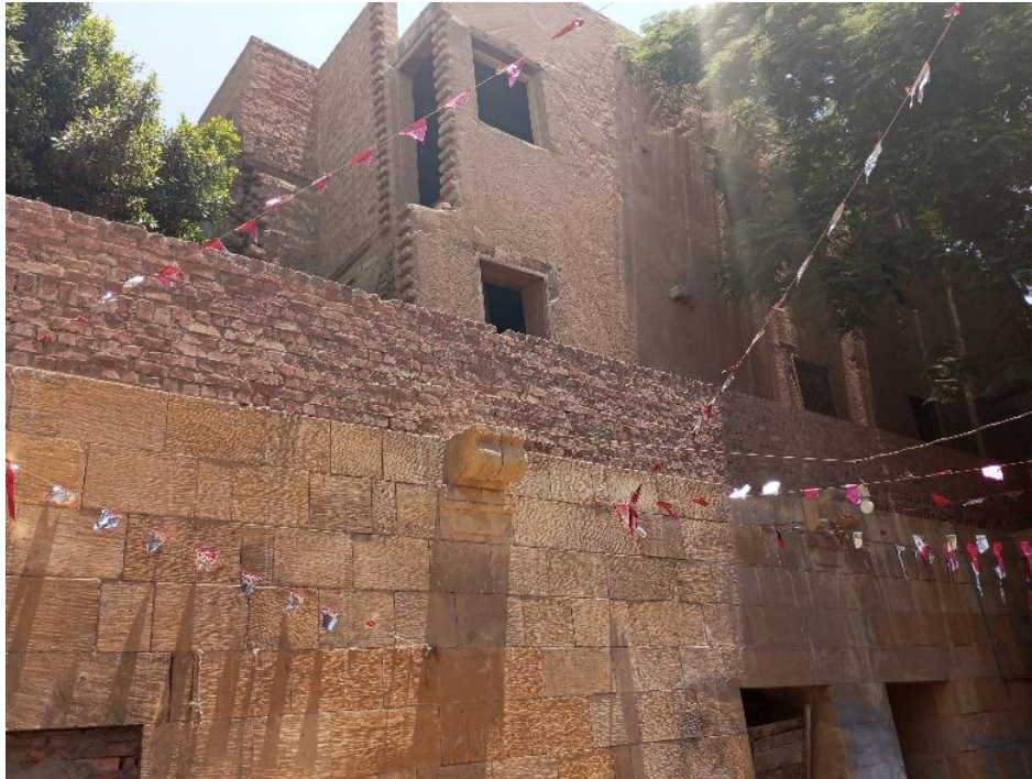
(لوحة 39) الواجهة الخلفية لربع القزلار ويظهر بقايا الربع العليا المعاد ترميمها.
