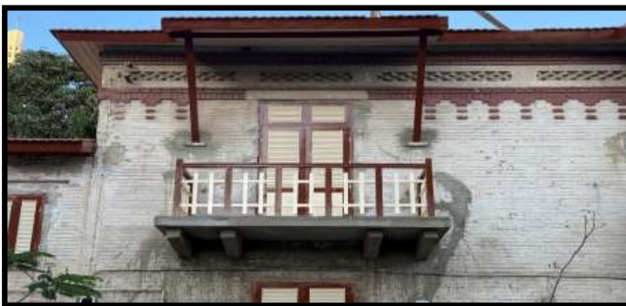
لوحة (١٧) تفاصيل لشرفة من الواجهة الرئيسية، تصوير الباحثة.
