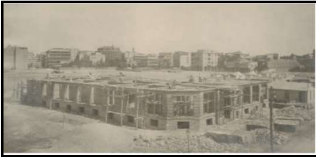
لوحة (٢) مبنى سكني مكون من ١٦ وحدة لموظفي شركة السويس، بورسعيد (حوالي عام ١٩١٩) قيد الإنشاء، بول ألبرت مهندس معماري، عن:
