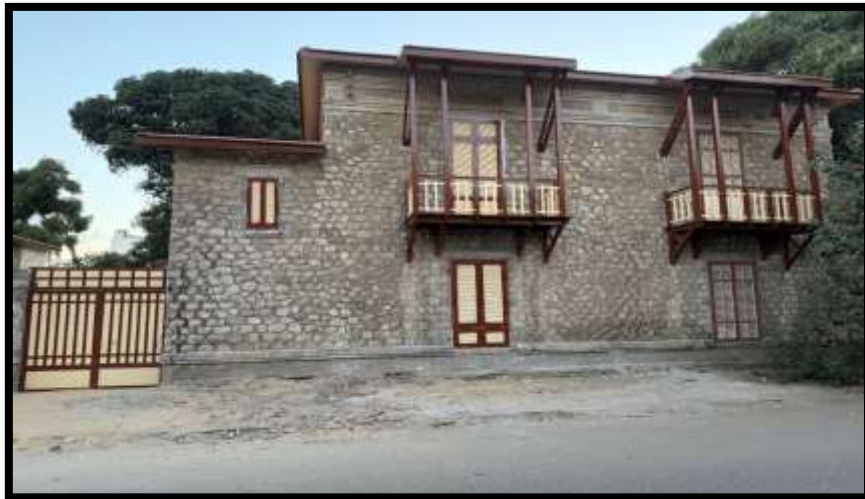
لوحة (٦) الواجهة الجنوبية الغربية لفيللا العمال نموذج ١ ، تصوير الباحثة.
