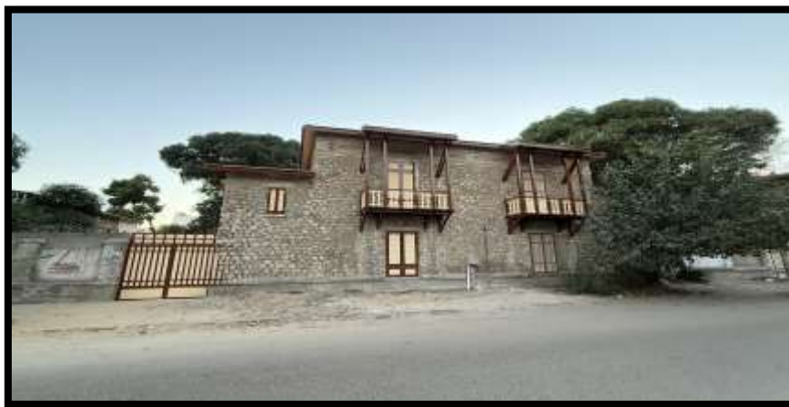
لوحة (٧) الواجهة الجنوبية الغربية لفيللا العمال نموذج ١ ، تصوير الباحثة.
