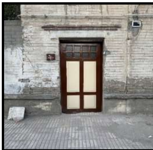
لوحة (١٤) الباب الرئيسي بالواجهة الرئيسية، تصوير الباحثة.
