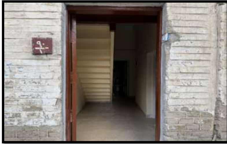
لوحة (١٩) المدخل الرئيسي وسلم الطابق العلوي، تصوير الباحثة.
