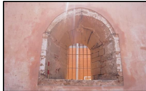
لوحة (١٣): فتحات رمي المدافع بالسور الشمالي الغربي. تصوير الباحث.
