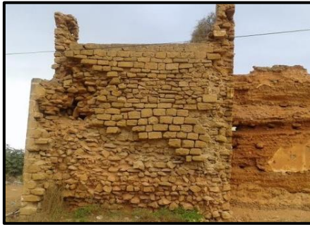
لوحة (١٦): توضيح تقنية البناء بالأحجار في البرج الجنوبي. عن: https://m.le360.ma/culture/diapo
