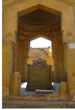
لوحة رقم (١١) الفتحة التي تتوسط الواجهة الشمالية الغربية لمقصورة الدفن الرئيسية الخاصة بالمدفن. " تصوير الباحثة "
