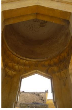
لوحة رقم (١٨) الحنايا الركنية الخاصة بمنطقة انتقال القبّة من الداخل بمقصورة الدفن الرئيسية الخاصة بالمدفن. " تصوير الباحثة "
