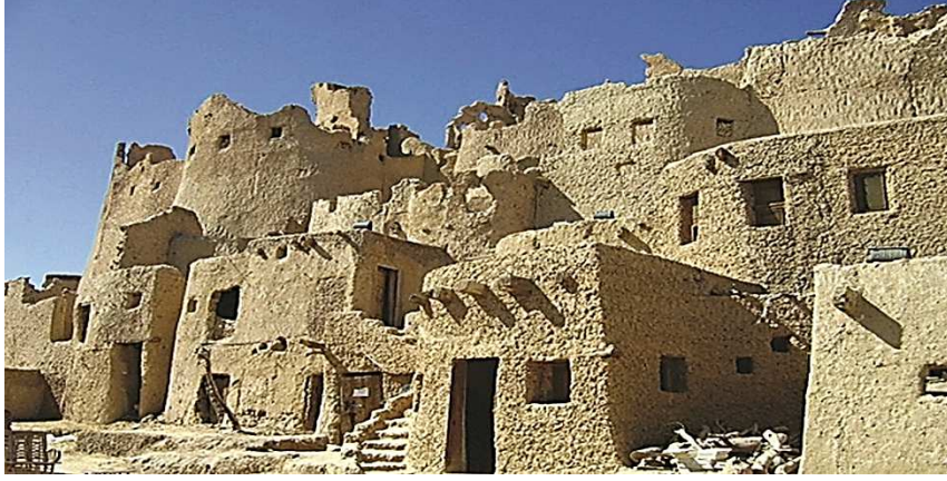
(شكل ٢): طرز المباني القديمة بواحة سيوة. نقلاً عن:
