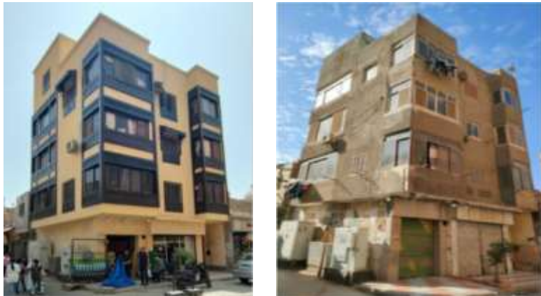
شكل رقم (١٠ - ب)، نماذج من تطوير وترميم واجهات المباني السكنية بمنطقة مسجد الحاكم (٢٥)
