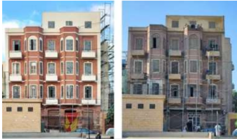
شكل رقم (١٠ - أ)، نماذج من تطوير وترميم واجهات المباني السكنية بمنطقة مسجد الحاكم (٢٥)
