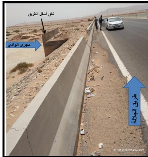
صورة (٥) أنفاق عبور مياه السيول تحت طريق الجلالة بوادي عربية (لاحظ مستوى آثار عبور مياه السيول)، ناظرًا صوب الشرق.
