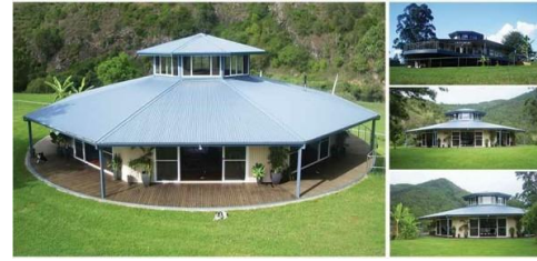
شكل رقم (3) يوضح المنزل المتحرك House حركه دورانيه عي منصه فولاذيه طولها 87 قدم وبسرعه 525 قدم تتيج للمنزل أن يدور في كل الإتجاهات ويمكن للمنزل أن يأخذ جولتين خلال ساعه
