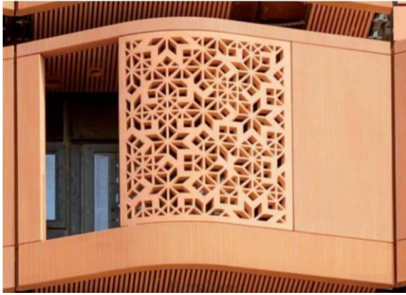
شكل(20) تفصيلية من الواجهة تظهر الستائر الخرسانية توضح جمال التشكيل في المشربيات باستخدام خامة GRC - المصدر: السفطي، 2021م، ص110
