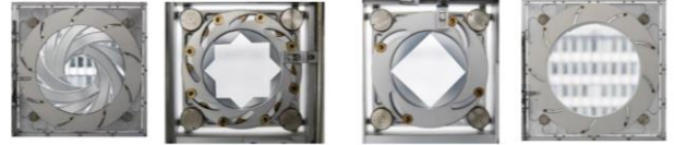
شكل (24) مراحل إغلاق العدسة وفقاً لضوء الشمس الخارجي لتوفير
