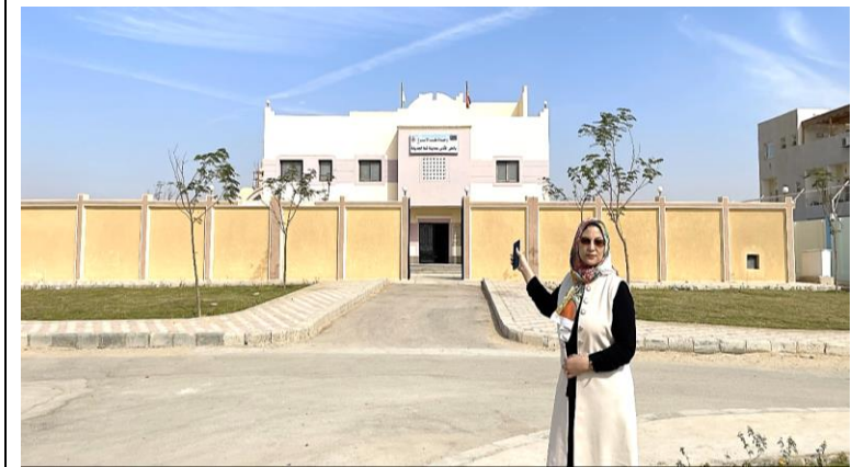
(ج) وحدة طب الأسرة بالحي الثاني بالمدينة
