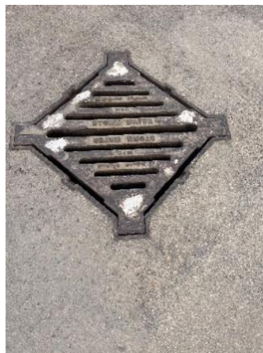
شكل رقم ٢٣: فتحات التصريف
