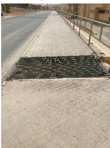
شكل رقم ٤٢: منطقة تصريف مياه الامطار في وسط مسار الحركة
