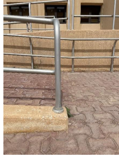
شكل رقم ٣١: عدم وجود امتداد خارجي لدرايزين
