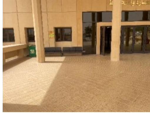
شكل رقم ٤٥ : مكان حاوية النفايات بجانب المدخل
