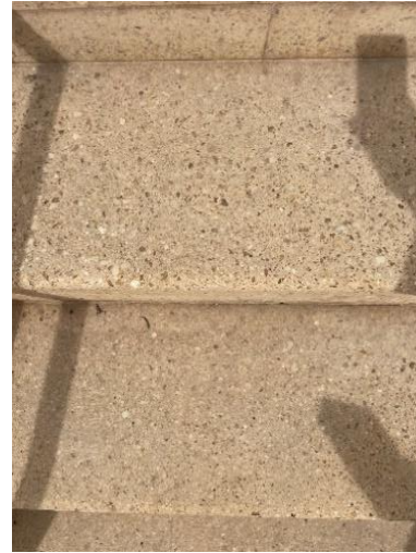
شكل رقم ٣٥: نوع مادة تشطيب الدرج
