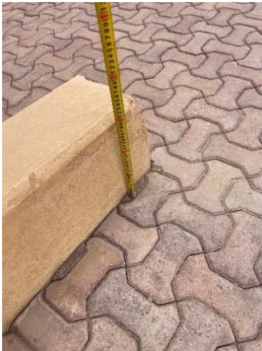
شكل رقم ٣٠: الحاجز الحجري للمنحدرات
