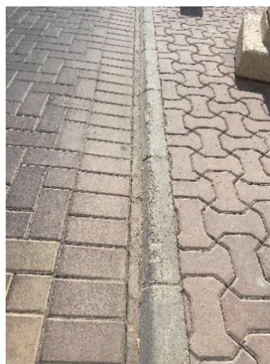
شكل رقم ٢٢: اختلاف المناسب في الممرات الخارجية
