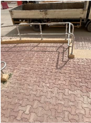
شكل رقم ٢٨: البسطة الوسطية للمنحدر بزاوية ٩٠ درجة
