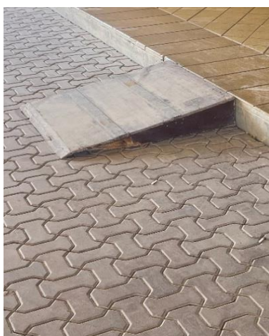
شكل رقم ١٣: مادة الخشب المستخدمة في المنحدر
