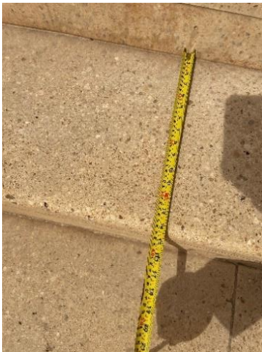
شكل رقم ٣٤: طول عمق الدرج
