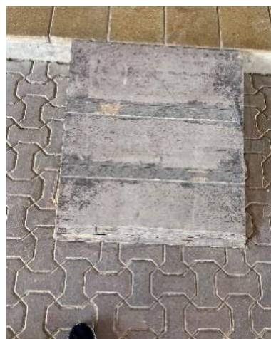
شكل رقم ١٢: مادة الخشب المستخدمة في المنحدر
