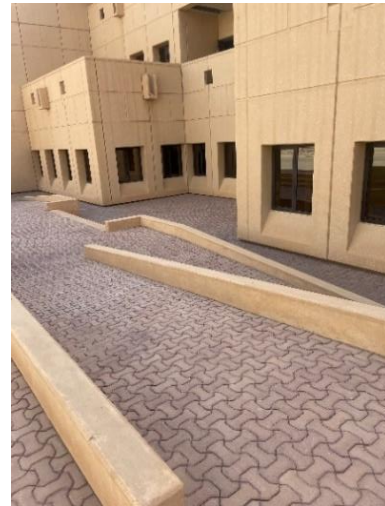
شكل رقم ٢٩: المنحدرات الخارجية بدون درابزين
