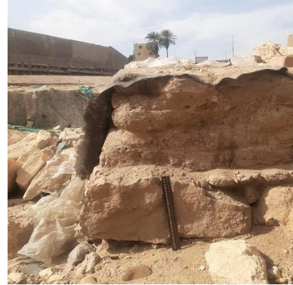
صورة (8): شكل وحجم بعض أحجار الأساسات، ويتضح بناء بعضها على مستوى سطح الأرض مباشرة.
