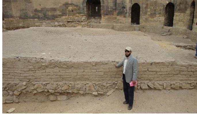
صورة (7): استخدام كتل الطوب اللبن في تشييد جزء من السور، بالقرب من برج الظفر، وتوضح الأساسات الحجرية، وارتفاع الجدار الطيني الذي لا يتجاوز 120سم.
