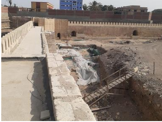
صورة (4): نفس الصورة السابقة، من تصوير الباحث عام 2023، ويتضح تغطية الجزء المكتشف من السور الطيني، وأعمال ترميم السور الحجري.
