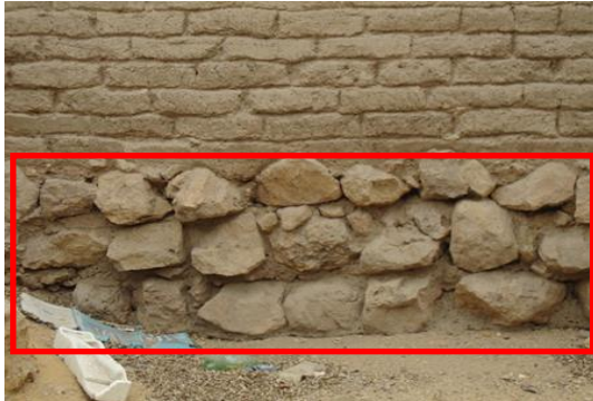
صورة (19): ضعف وتفكك المونة الطينية الرابطة بين أحجار الأساسات وتساقطها، تحتاج إلى الترميم
