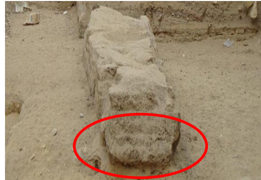
صورة (18): فقد كتل الطوب من الأجزاء السفلى من السور، تحتاج إلى ترميم عاجل
