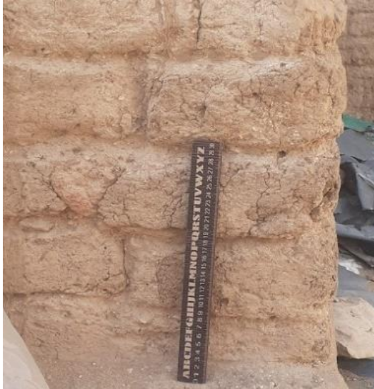
صورة (6): قياس أبعاد قوالب الطوب اللبن في الجزء الواقع بالقرب من البرج رقم 40، ويتضح تشابه أبعاد الطوب.
