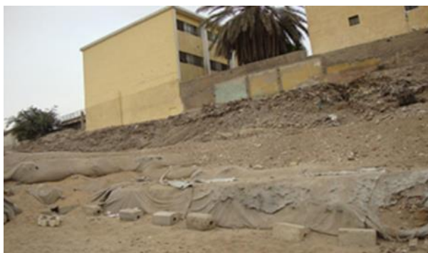
صورة (12): تلف السور الطيني بفعل الدفن وعوامل التعرية.
