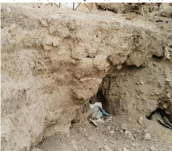
صورة (14): تلف وتدهور مباني السور الطيني، وتشوه معالم الطوب اللبن، وفقد في كتل الطوب.
