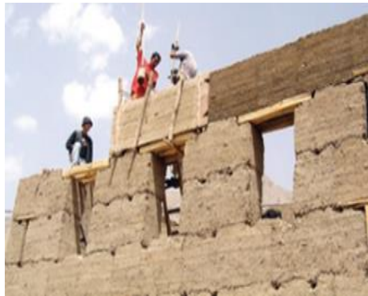
صورة (10): طريقة بناء الجدران الطينية بتقنية الطابية (عن: Hamdouni, 2009)
