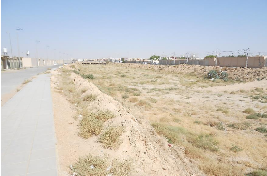
صورة فوتوغرافية (٨) جانب من منشآت درء أخطار السيول القائمة (حواجز التهذيب) في مدينة الخرج بتاريخ فبراير ٢٠٢٣ م المصدر: من عمل الباحث اعتمادًا على الزيارة الميدانية للباحث
