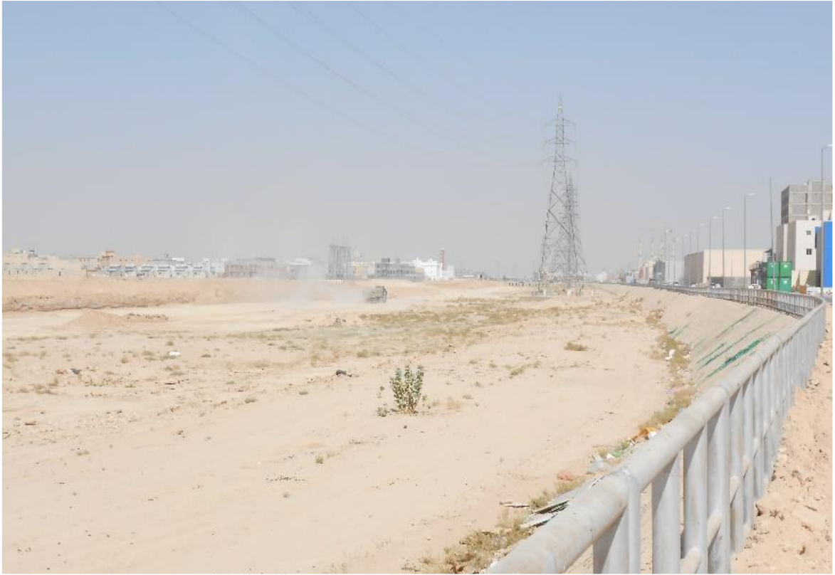
صورة فوتوغرافية (٧) جانب من منشآت درء أخطار السيول القائمة (حواجز التهذيب) في مدينة الخرج بتاريخ فبراير ٢٠٢٣ م المصدر: من عمل الباحث اعتمادًا على الزيارة الميدانية للباحث
