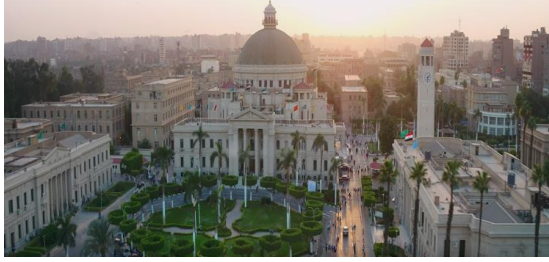
شكل (١٢) مبني القبة بجامعة القاهرة Source: (Cairo University, 2018)
