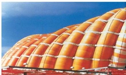
شكل رقم ١٧- يوضح استخدام اللدائن في المنشآت المنفوخة، معرض فوجي باليابان المصدر: [www.tensinet.com](http://www.tensinet.com)
