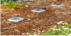
شكل رقم ٣٢ - إضاءة طرق الحدائق الشمسية<sup>٤٧</sup>
