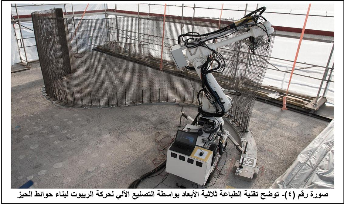
صورة رقم (٤)- توضح تقنية الطباعة ثلاثية الأبعاد بواسطة التصنيع الآلي لحركة الروبوت لبناء حوائط الحيز
