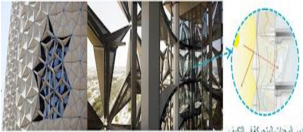
شكل ١٥: يوضح الوحدات المتحركة المكونة لنظام الغلاف ودورها في التكيف (Karanouh, Kerber 2015)
