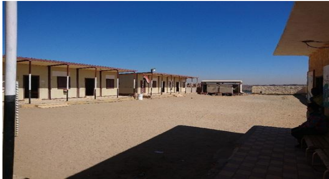
شكل (3) صورة توضح المدرسة الابتدائية الوحيدة وتظهر في الواجهة دورات المياه المتهالكة
