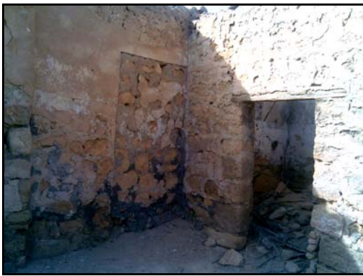
صورة رقم (١٢) حائط معالج باستخدام تقنية التّرقيع
