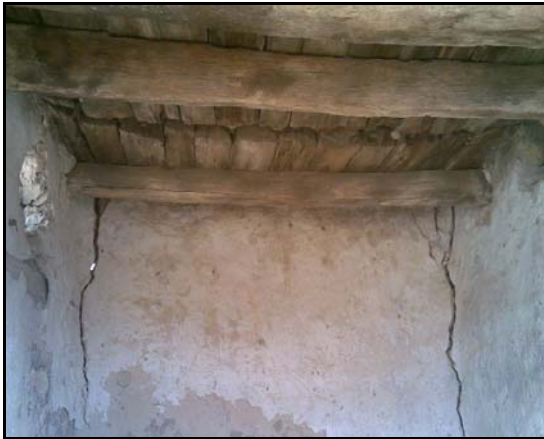
صورة رقم (٥) "السقف" خشب النخيل المادة الأساسية
