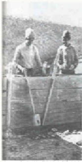
صورة تمثل طريقة البناء بالطابوت الطابية
