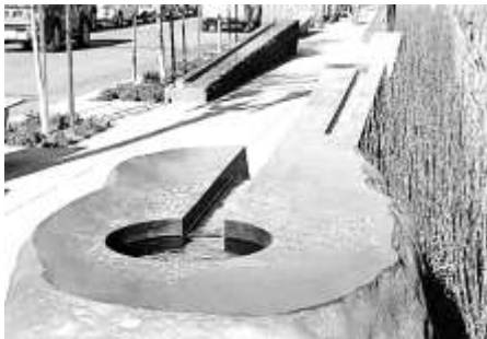
شكل 7. يوضح وحدات تجميع مياه الأمطار الخارجية (20)
