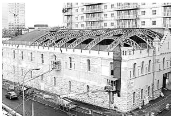
شكل 9. يوضح المبنى في فترة إعادة الترميم (19)
