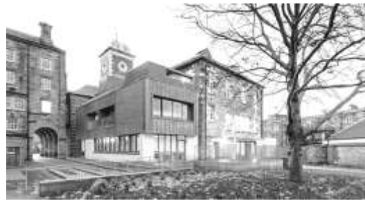
شكل 10. يوضح الواجهة الخارجية للمبنى (26)
