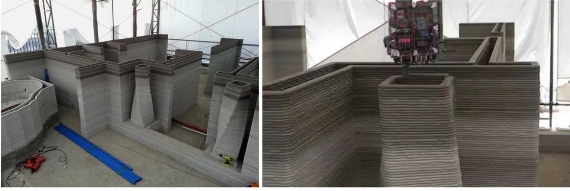
شكل (4) يوضح صورة لمبنى تم تشييده بواسطة طابعة ثلاثية الأبعاد، باستخدام الخرسانة – المصدر [www.totalkustom.com](http://www.totalkustom.com)
