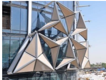
شكل (٧) يوضح واجهات "أبراج البحار" والكاسرات الشمسية التي تستجيب لضوء الشمس لتحقيق مناخ مناسب داخل المبنى، https://www.albayan.ae/editors-choice/asfar/2015-11-23-1.2512401
