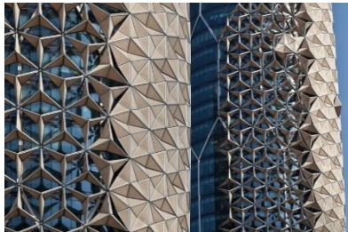
شكل (٧) يوضح واجهات "أبراج البحار" والكاسرات الشمسية التي تستجيب لضوء الشمس لتحقيق مناخ مناسب داخل المبنى، https://www.albayan.ae/editors-choice/asfar/2015-11-23-1.2512401
